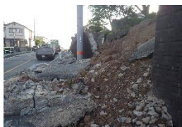
ブロック塀が道路へ
